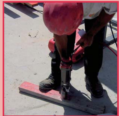
Verbindung Holz und Beton
