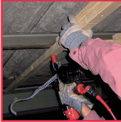
Verbindung Holz und Stahl
