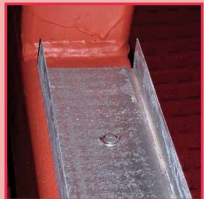
Verbindung C-Profil und Stahl
