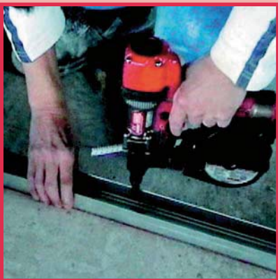
Verbindung C-Profil und Beton
