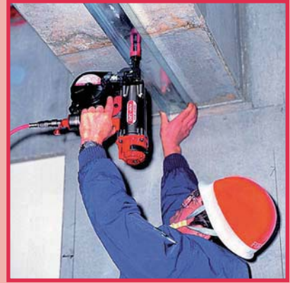
Verbindung C-Profil und Stahl
